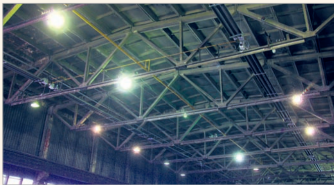
Тепловые лучи от инфракрасных излучателей, установленных под потолком, обогревают равномерно весь цех.
