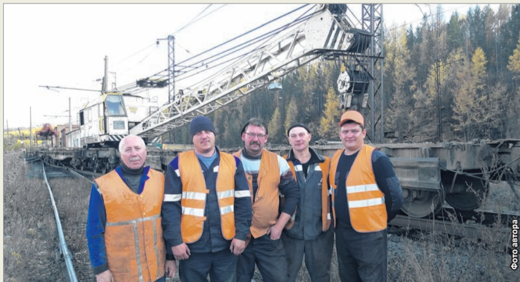
Бригада службы пути: бригадир Николай Похильченко , машинист крана Алексей Мартянов , монтеры пути Сергей Бурьян и Александр Мальцев , и.о. мастера Александр Котельников
